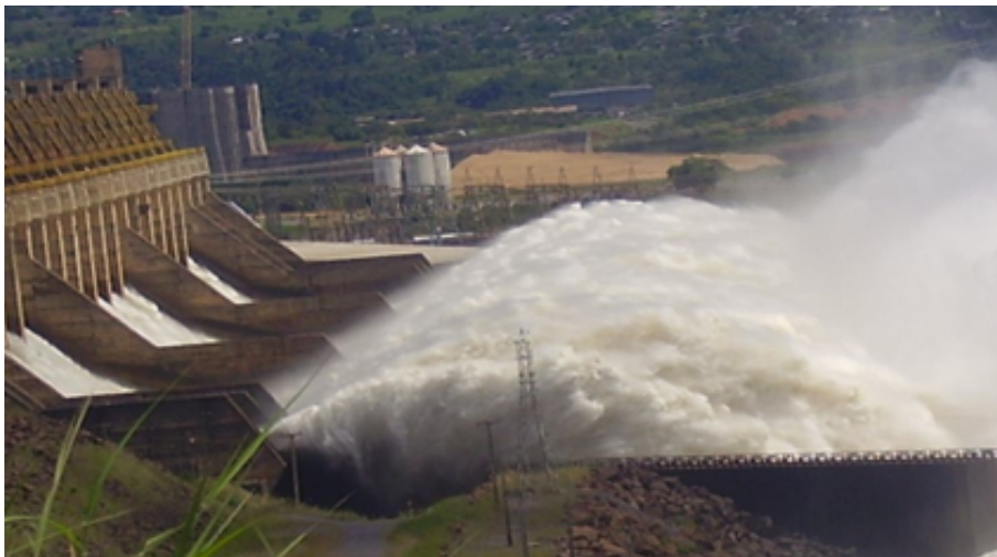
Foto 4 - Vertedouro da represa da UHE de Tucuruí
