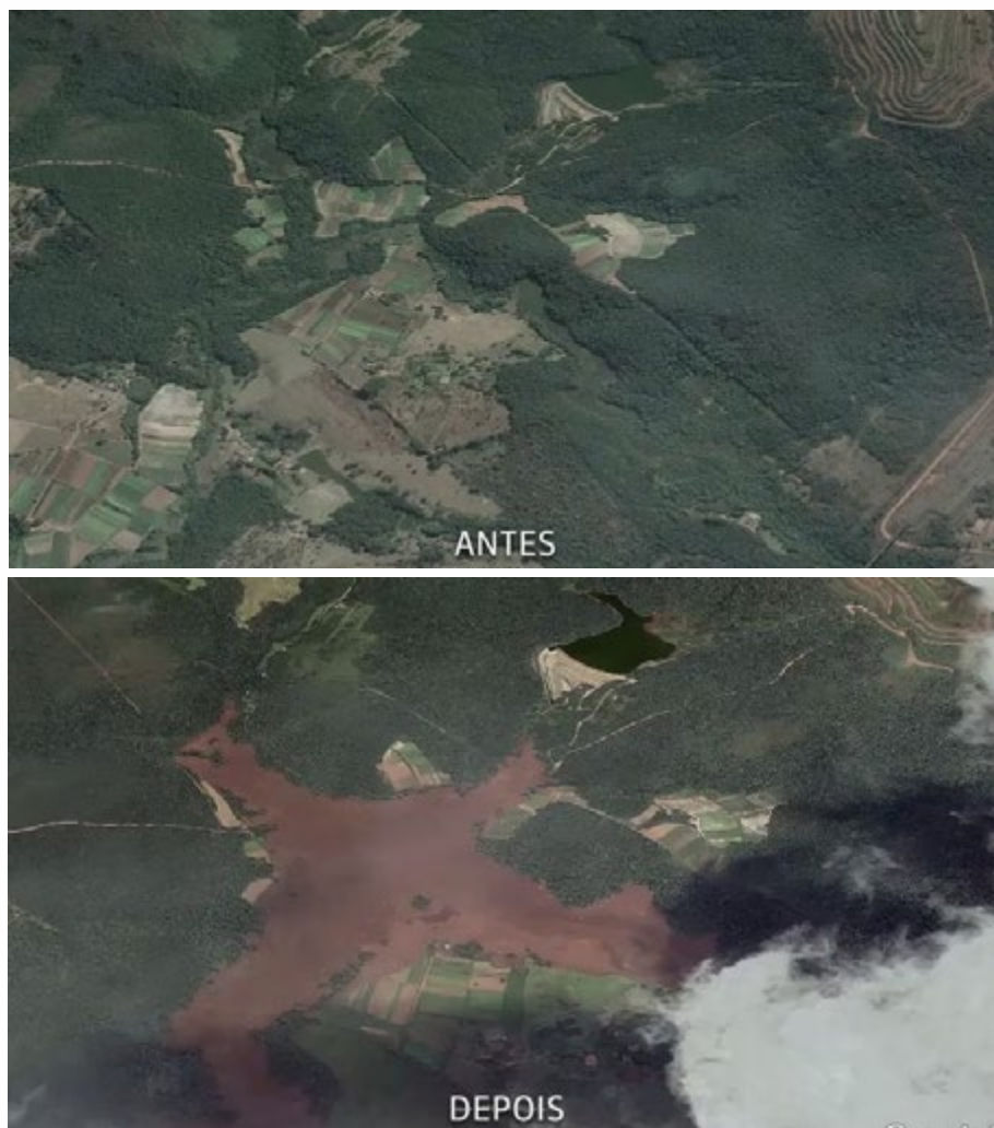
Figura 2 - Imagens aéreas do antes e depois do rompimento da barragem da Vale S.A. em Brumadinho (MG)
